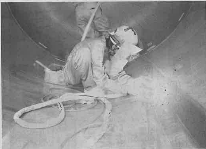
チタンライニングの溶接
