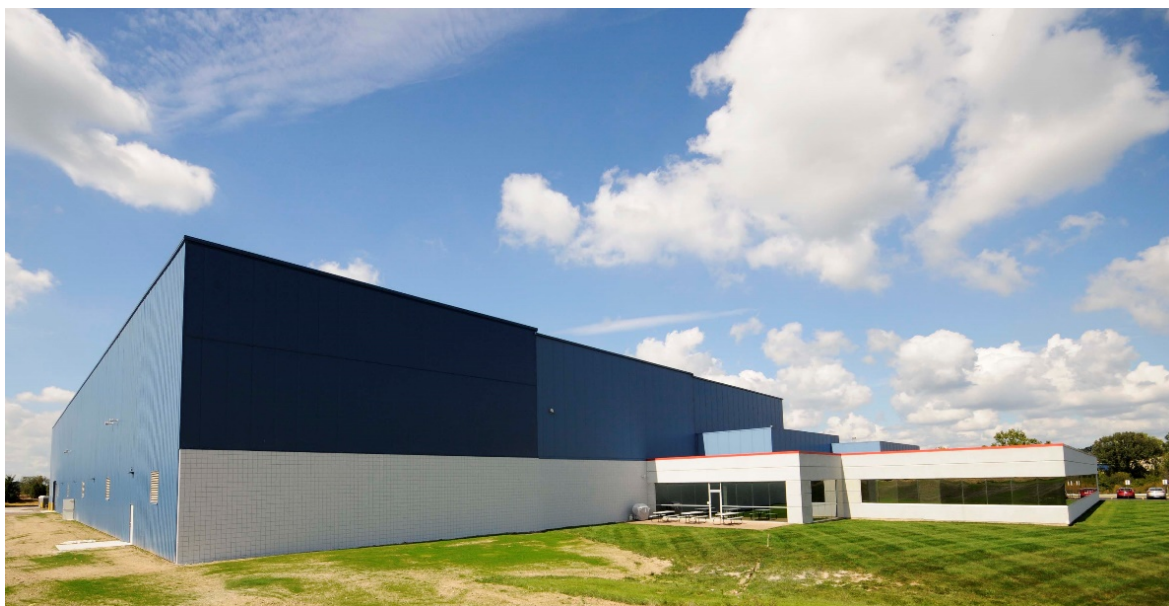
拡張工事が完了した工場
