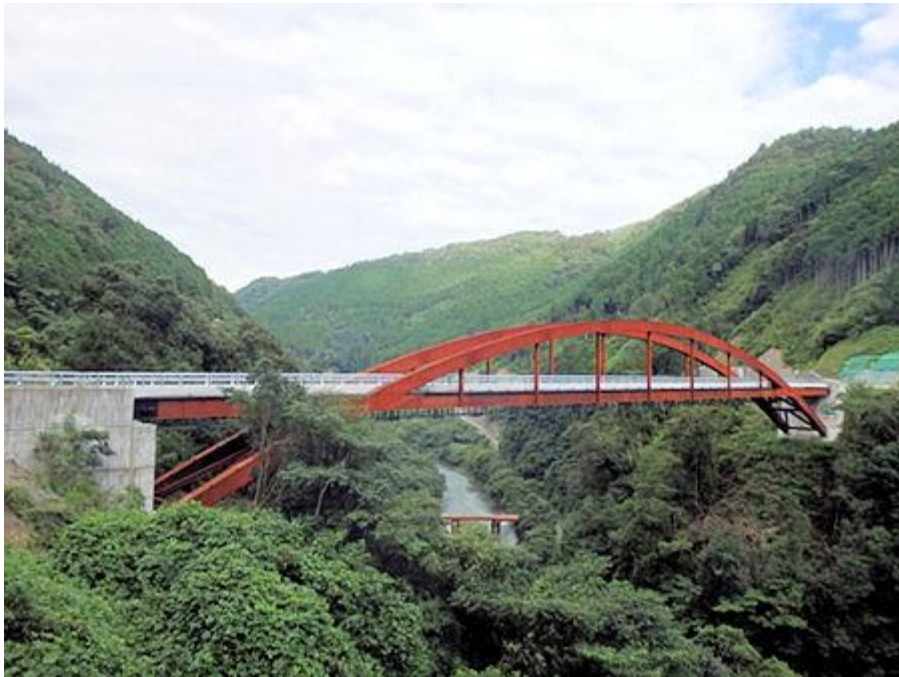
完成した足瀬橋
