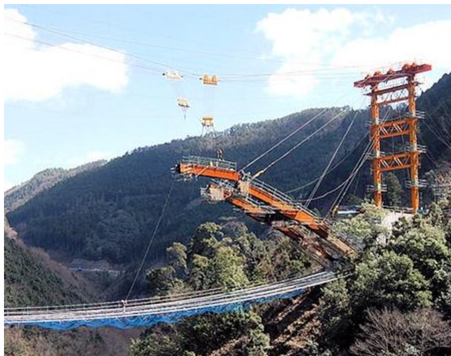
「斜吊工法」による架設
