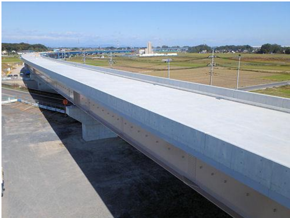
五霞地区高架橋 五霞 10 号橋
