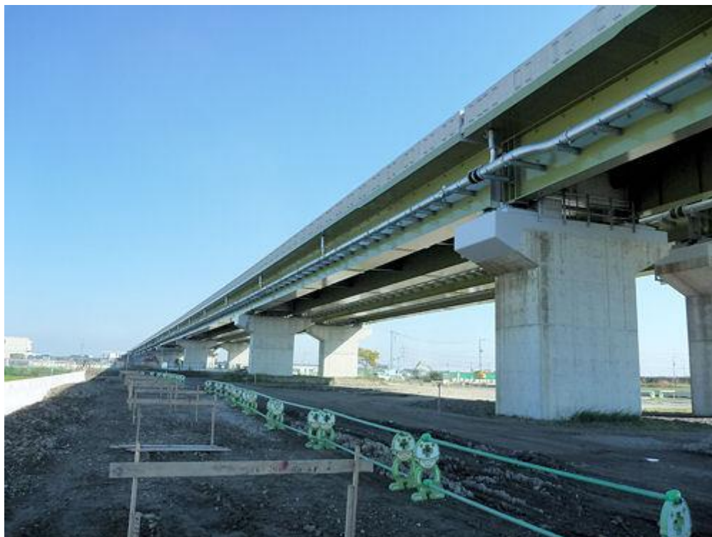
幸手地区高架橋 赤木裏第二高架橋(桁下)
