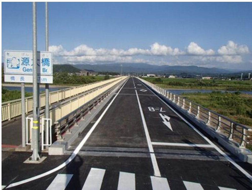
架設完了状況
