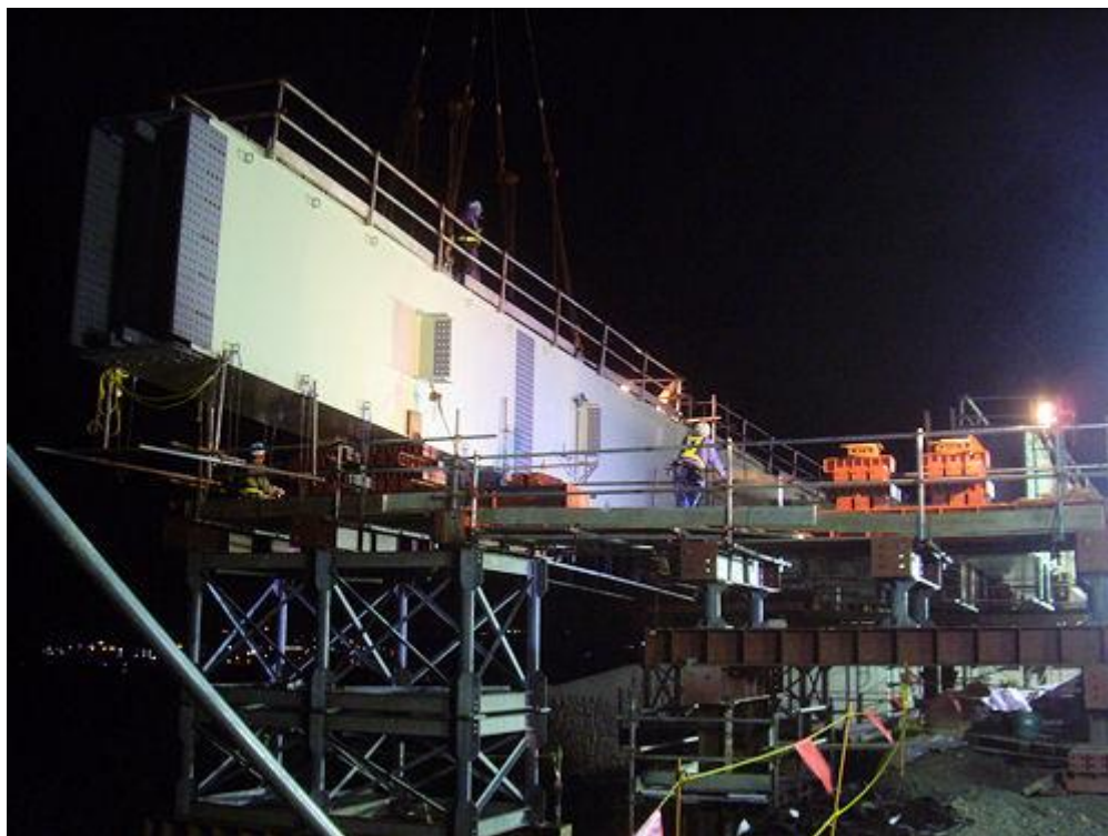
夜間架設状況
