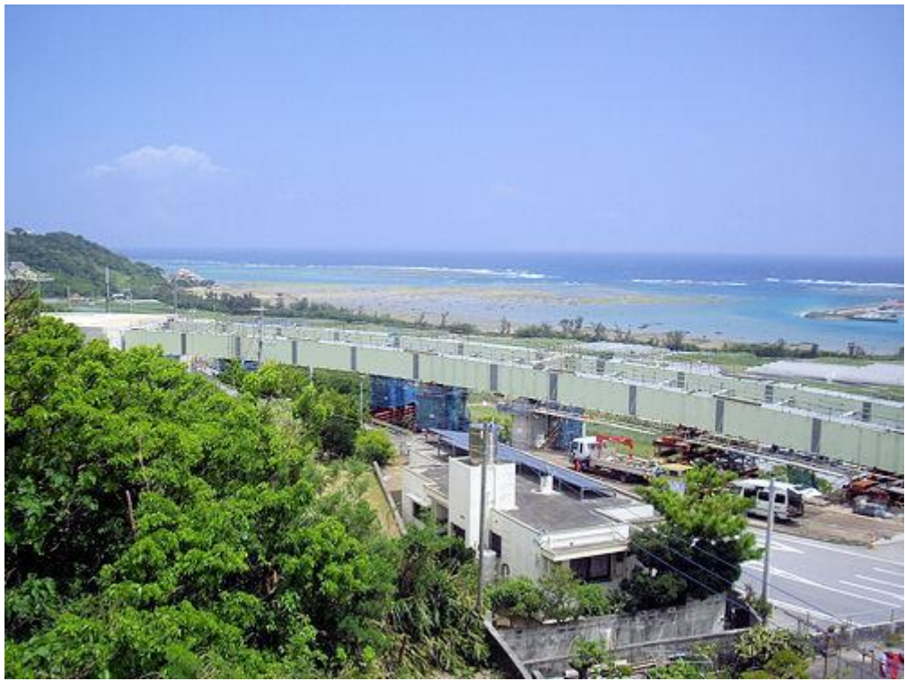
架設完了状況
