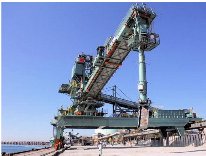
加古川製鉄所構内 据付完了
