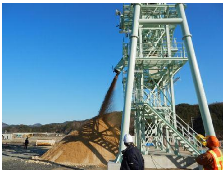
始動後のベルトコンベヤの状況（排出口から大量の土砂が排出される）
