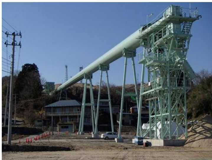
完成した織笠ベルトコンベヤ全景写真（民家の上を渡る静音タイプコンベヤ）
