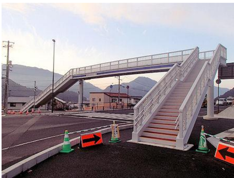
三入横断歩道橋の完成写真
