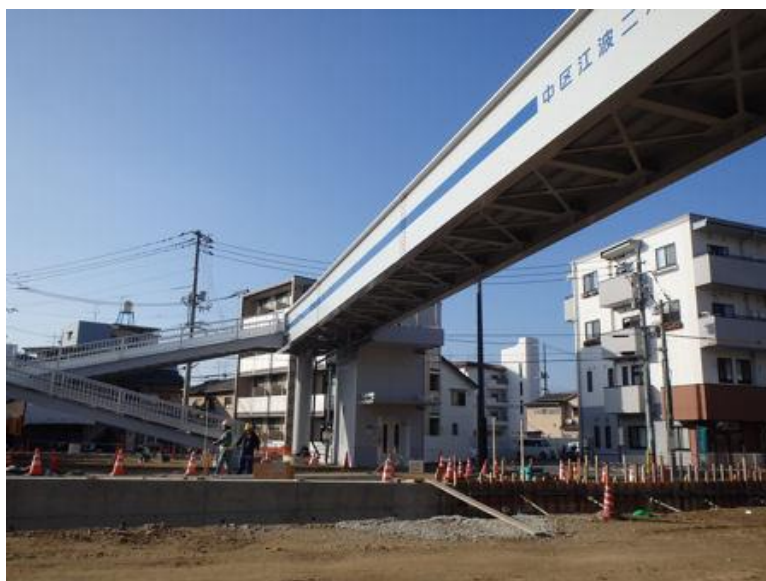
江波横断歩道橋の完成写真
