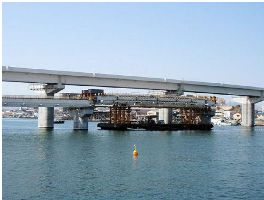
ポンツーン架設状況
