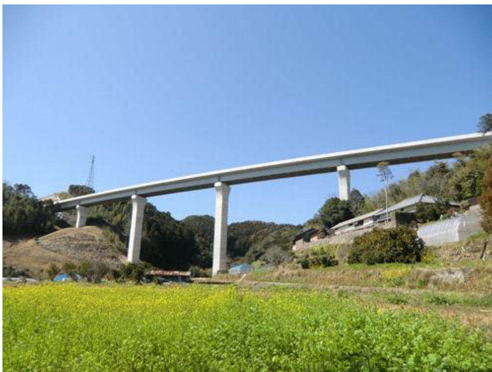
当社が施工した石田川橋
