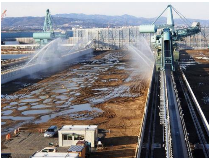
貯炭場散水・ヤードマシン給水設備
