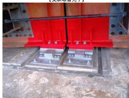
【伸縮装置取替完了】
