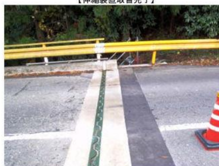
【伸縮装置取替完了】
