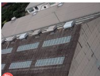
Fig. 8 工場天井の明かり取りの追加
