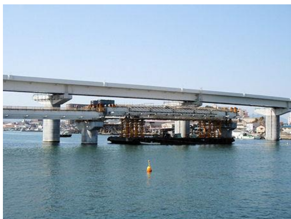
ポンツーン架設(台船架設)による施工
