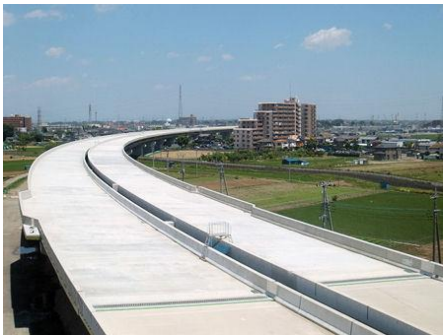
起点側より(第 1 橋 右が上線・左が下線)
