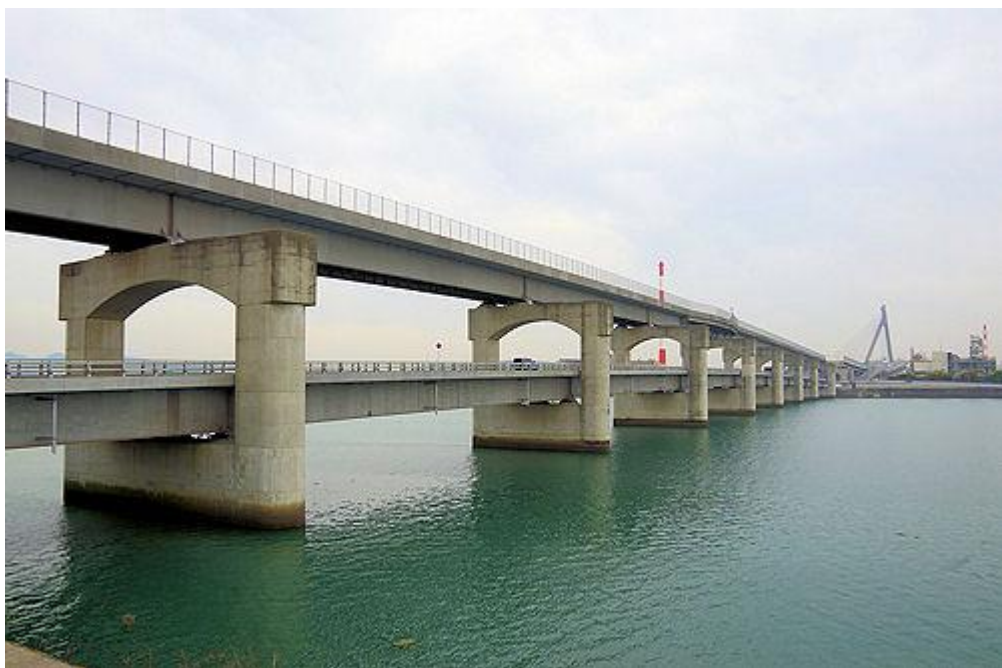
県内初のダブルデッキ構造となる厚東川新橋
