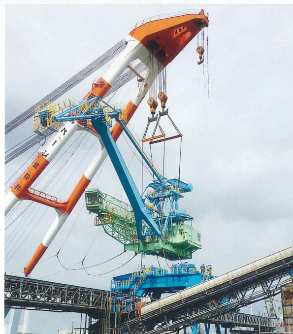
旋回部据付状況
