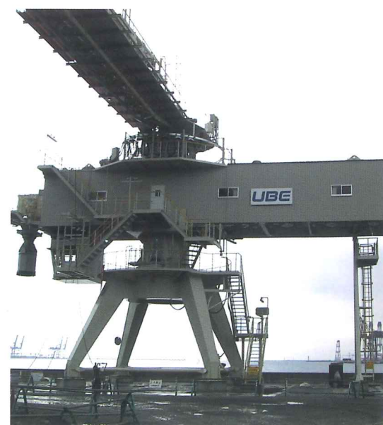
石膏湿灰船積用 能力 400t/h
