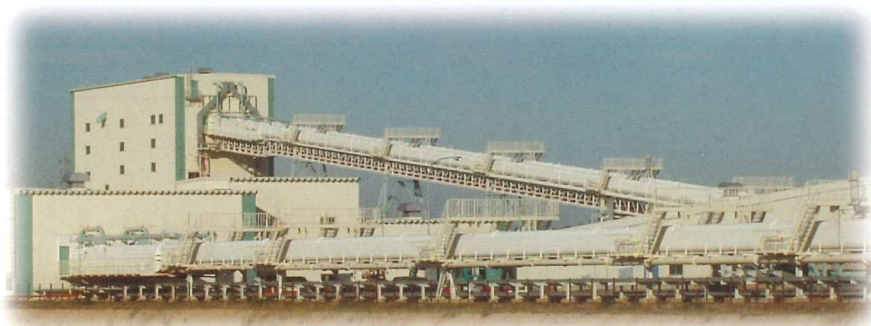
石炭コンベヤ 能力:1100t/h
