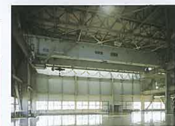
天井クレーン
