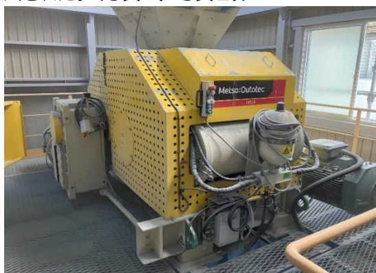
写真1．HPGR8設置状況
