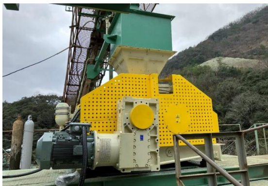
写真3. HPGR8設置状況
