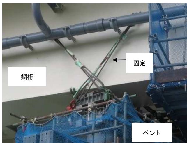
写真-3 ベントと桁の固定
