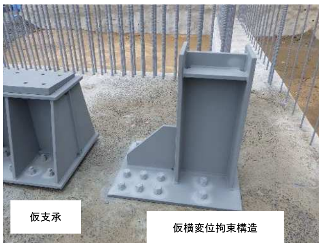
写真-4 仮支承と仮横変位拘束構造
