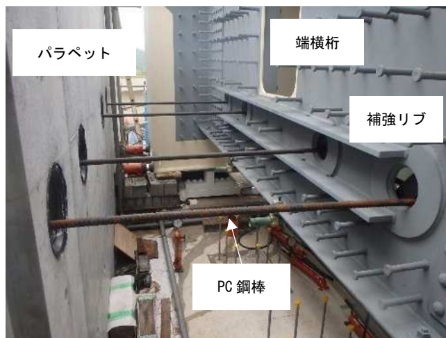
写真-2 橋台と桁の固定
