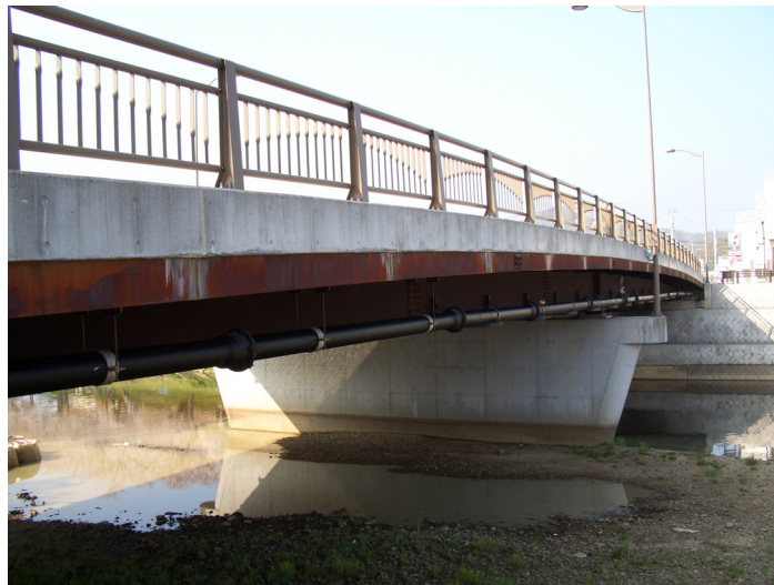
写真-1 さび画像を採取した橋梁
