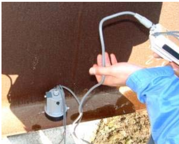
写真-1 調査状況写真(表面塩分計)
